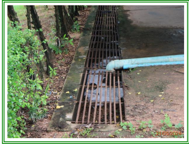
รูปที่ 3-40 รางระบายน้ำบริเวณโรงอาหารที่เป็นท่อพีวีซี (PVC)
