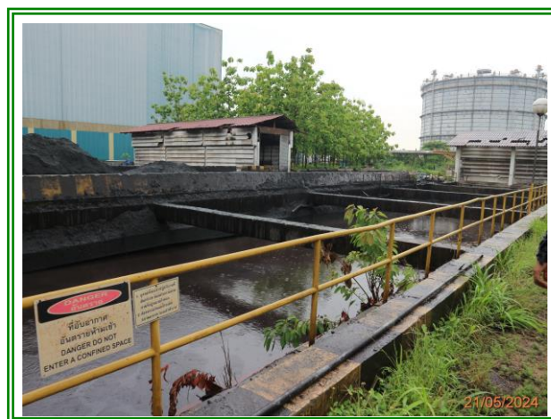
รูปที่ 3-19 ป่อพักน้ำหล่อเย็นเพื่อนำกลับมาใช้ใหม่
