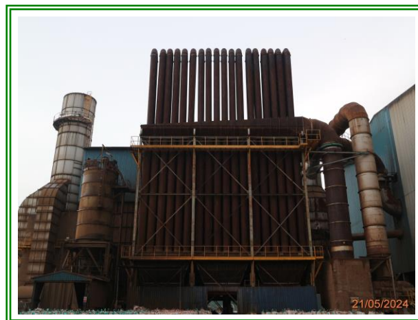
รูปที่ 3-2 อุปกรณ์ดักฝุ่นแบบถุงกรอง (Bag filter)
