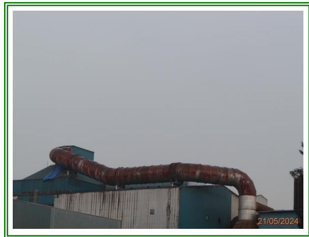
รูปที่ 3-14 ระบบดักฝุ่นแบบ Canopy Hood ที่ใช้ดูดฝุ่นละอองและ Fume ที่ล้าเสี่ยงเข้าไปบำบัดโดยผ่านระบบดักฝุ่นแบบถุงกรอง (Bag Filter)
